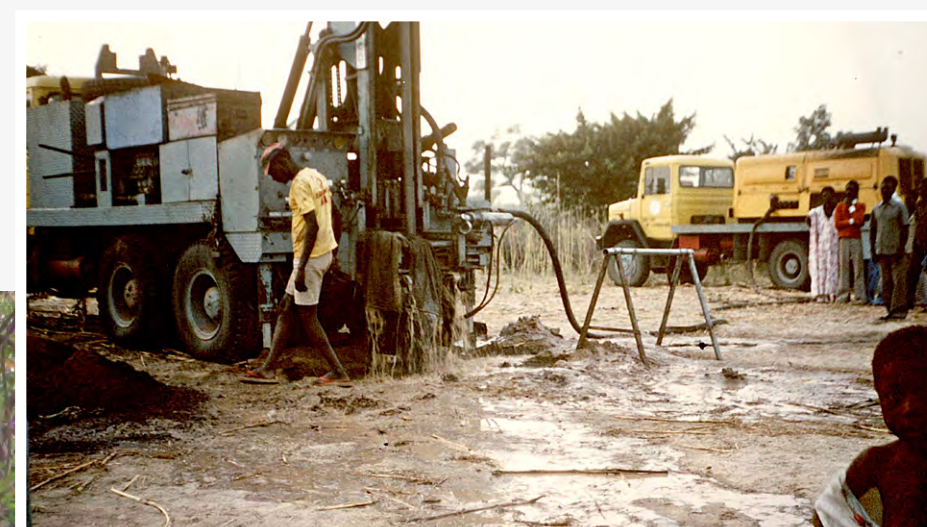
Village de Diéna, forage depuis la nappe d'eau phréatique (foreuse Verspeiren) AMA 17F12024
