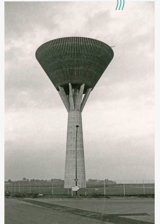
Château d'eau rue Lazare-Carnot DR, 1973 AMA 17F1523
