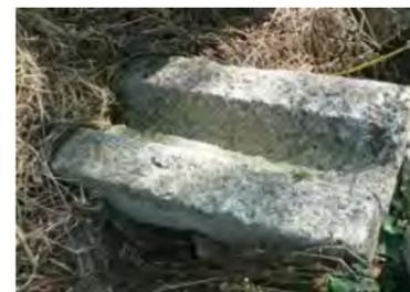
Ci-contre : dalles qui, posées face à face, permettent de canaliser l'eau et de l'acheminer vers le réseau de douves de Badoire (ci-dessous)
